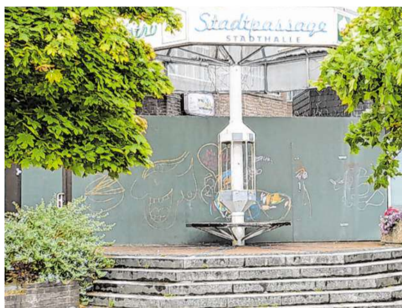
In einem katastrophalen Zustand ist der Synagogenplatz im Herzen der Stadt. Solange die Zukunft der ehemaligen Stadthalle ungewiss ist, kann er nicht ausgebaut werden.
